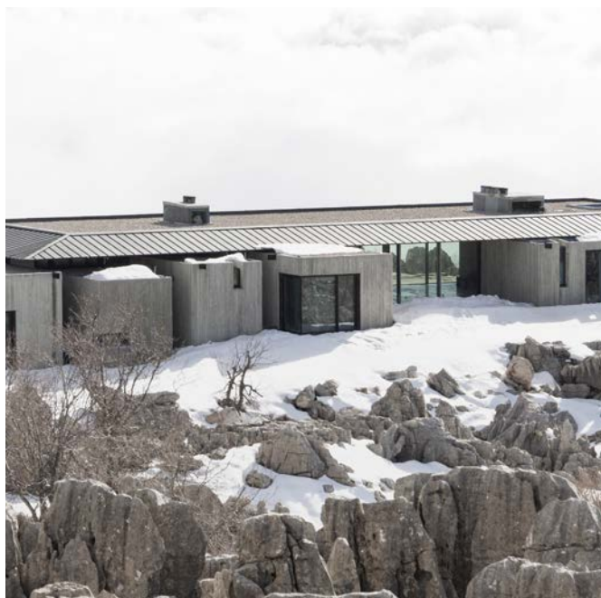
Cubierta en Junta alzada VMZINC® - ANTHRA-ZINC® - Arquitecto: Karim Nader Studio - Faqra - Líbano
